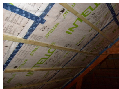
Isolation toiture + pare vapeur
