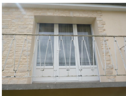
Isolation des murs par l'extérieur
