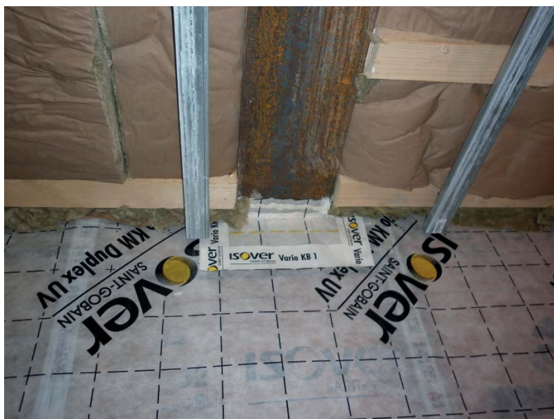
Frein-vapeur sur mur en pierre avec traitement de l'étanchéité à l'air au niveau de la poutre
