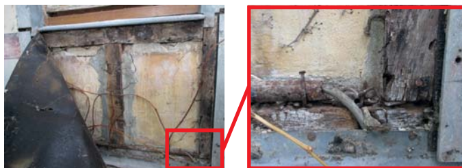
Mise à nu des pans de bois, sablière dégradée suite à mise en place d'un feutre bitumé côté extérieur et d'un polystyrène côté intérieur
